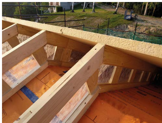
Dettaglio del tetto: la struttura dei telai in legno U*psi per l'insufflaggio dei fiocchi di cellulosa, chiusa dai pannelli in fibra di legno.
