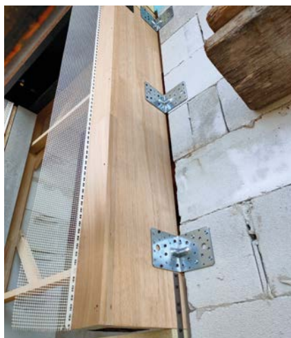
Fissaggio meccanico dei controtelai a balzo alla struttura in c.a.a.
